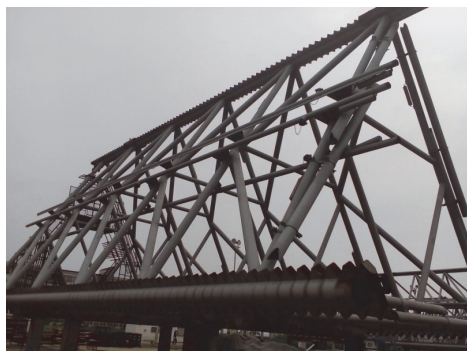
图1 某段桁架式桩腿现场
