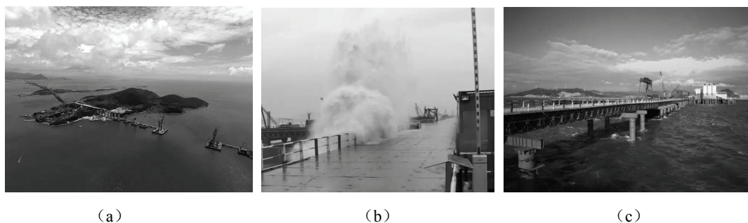
图 1 平潭海峡公铁两用大桥及海上栈桥
